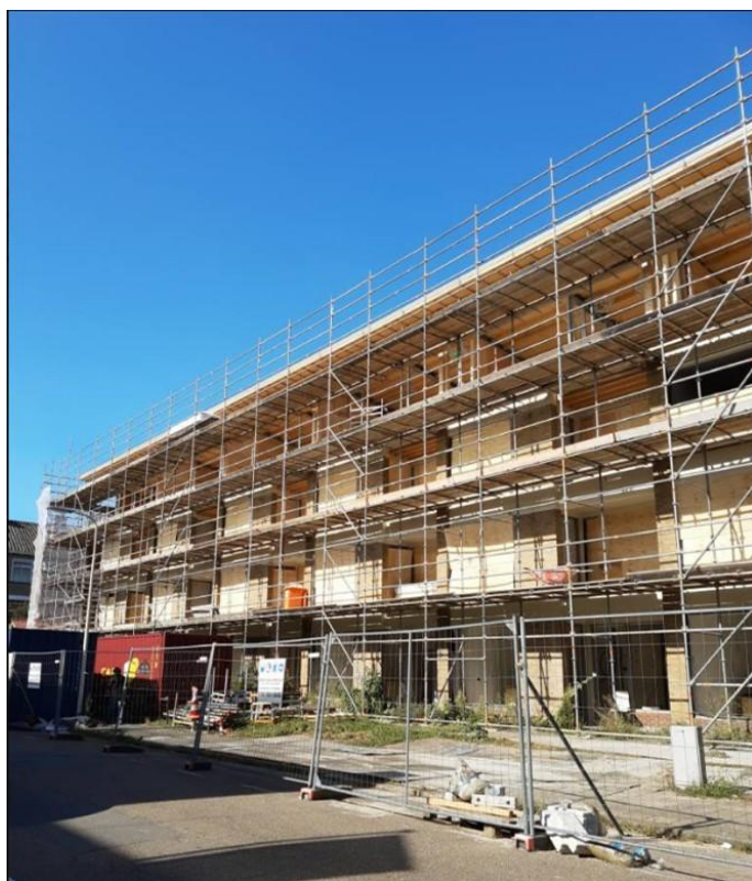
Figuur 12: Campanulastraat 27-85 in Den Haag tijdens cascorenovatie en optoppen
